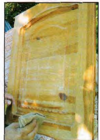
Сложные поверхности пришлось зачищать вручную.
