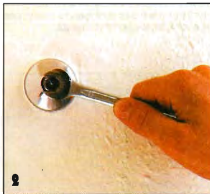
Заглушкой перекрывают трубу к высоко навешенному бачку. Можно установить здесь декоративную накладку.
