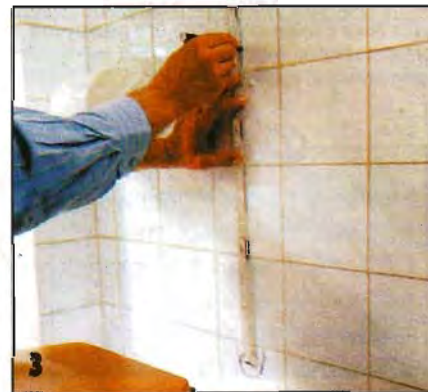
Карандашом размечают на стене за унитазом положение нового бачка. Исходная точка — середина унитаза.
