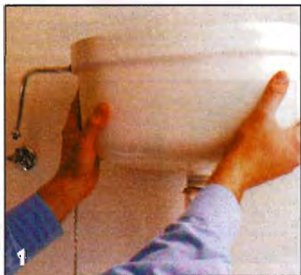
Перекрыв подачу воды к старому бачку, отсоединяют подводную и сливную трубы и, отсоединив старый бачок, снимают его.
