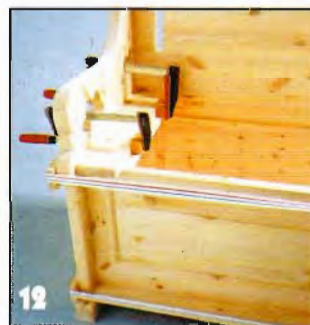
12 Струбцины и ленточные стяжки нужны при сушке клея в соединениях после сборки. Дно и ножки приворачивают шурупами.
