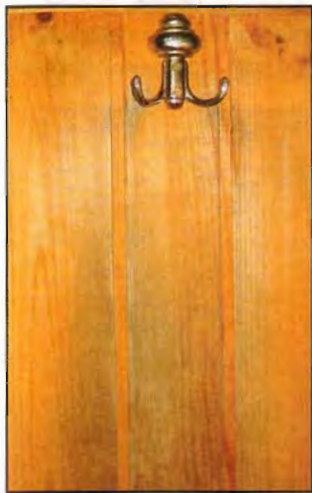
Вот здесь обычно висит кухонное полотенце. Хотя вагонка и была обработана «Пинотексом», влага сделала свое «черное» дело.
