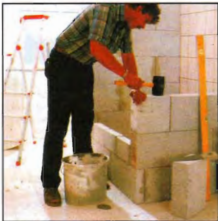
Резиновый молоток поможет подровнять блок и возвести стену вертикально.
